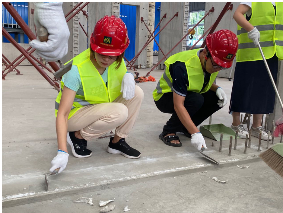
装配式项目教学实训操作
